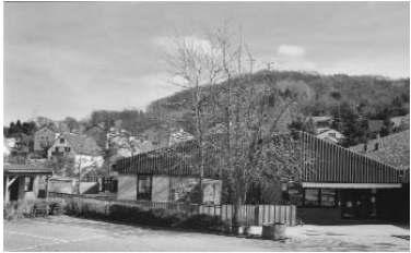
Das Kommunale Gemeindezentrum erhält neues Dach - Kindergarten im festen Ausweichquartier
